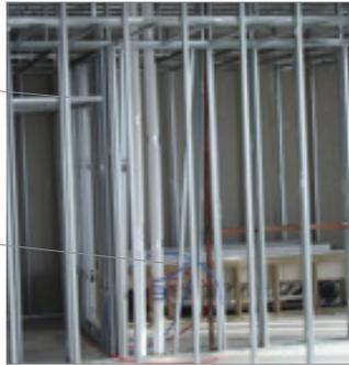
Nervures de raidissement Bailey au jambage, offrant une résistance supérieure
